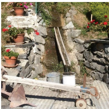
Captage vernaculaire avec des seaux et une rigole en bois
