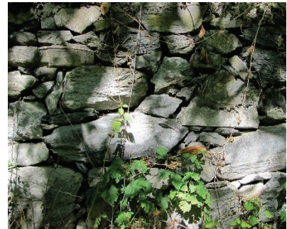
Murets de pierres sèches
