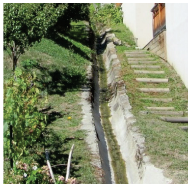
Chenal bétonné à travers un talus entre deux habitations
