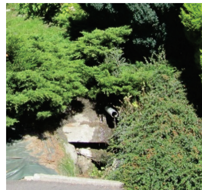
Source captée, empierrée et végétalisée
