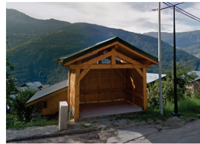
Abri bus en bois le long de la D89
