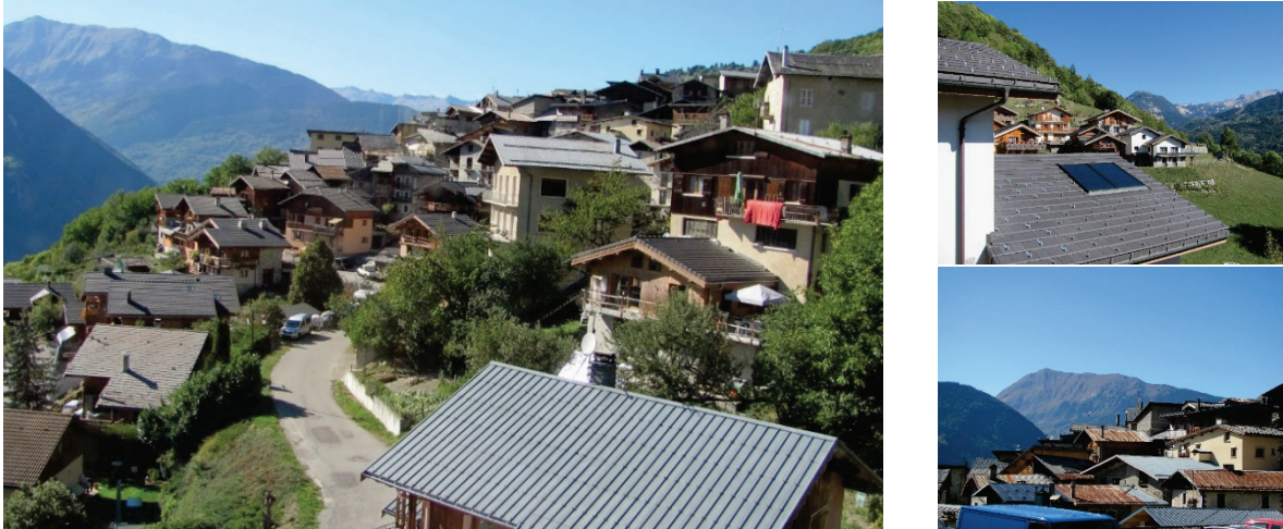
Photo 25 : Vue depuis la terrasse du bar restaurant sur une partie des toitures du Chef-Lieu
